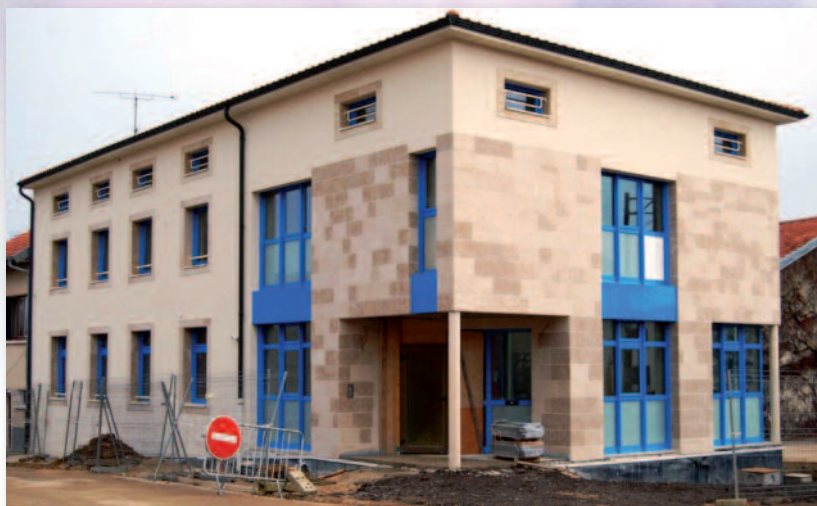
La nouvelle mairie en construction
